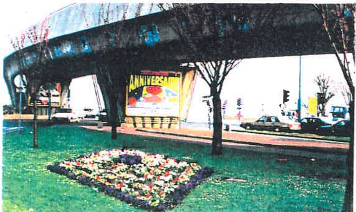
Perte de lisibilité des ouvrages par des décors et surcharges divers
