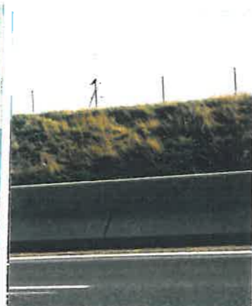
Clôtures isolant l'infrastructure
