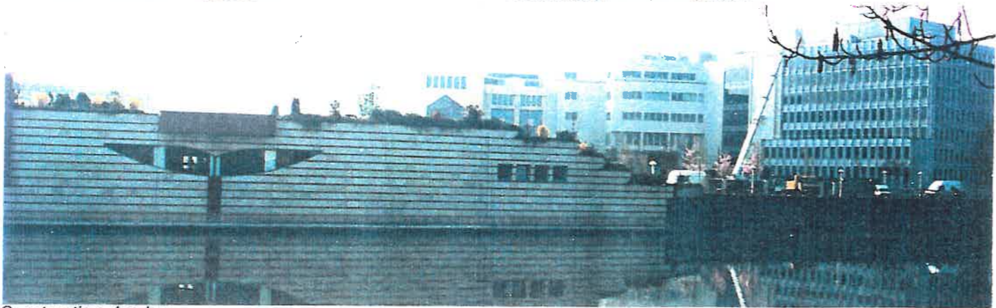
Construction des berges
