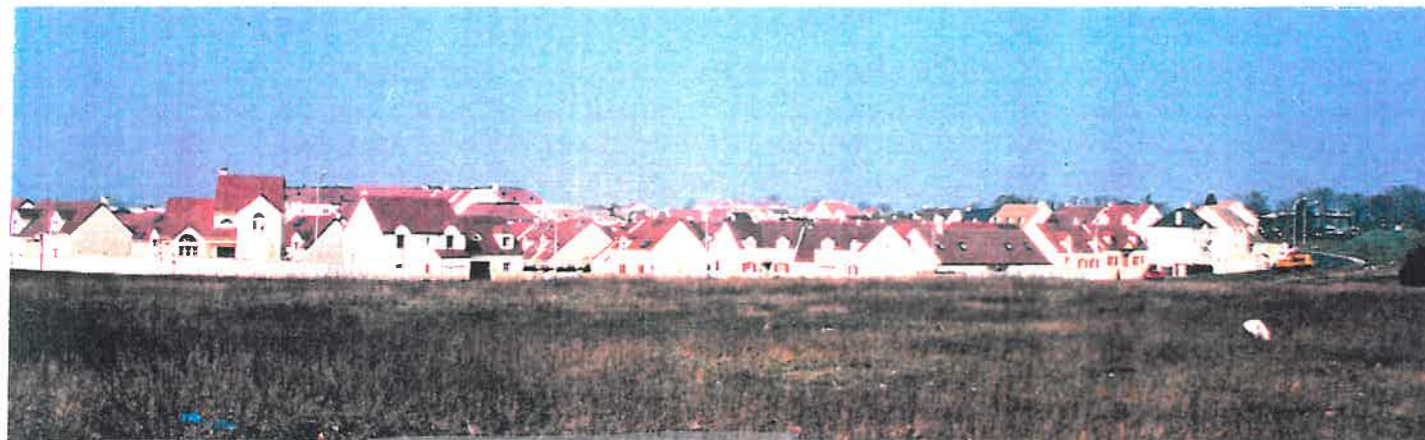
Perte de la perspective visuelle due à l'homogénéité du lotissement
