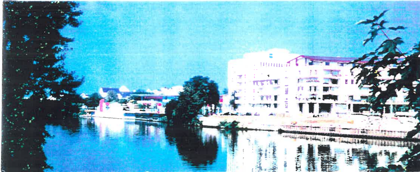
Berge occupée par des logements - état existant
