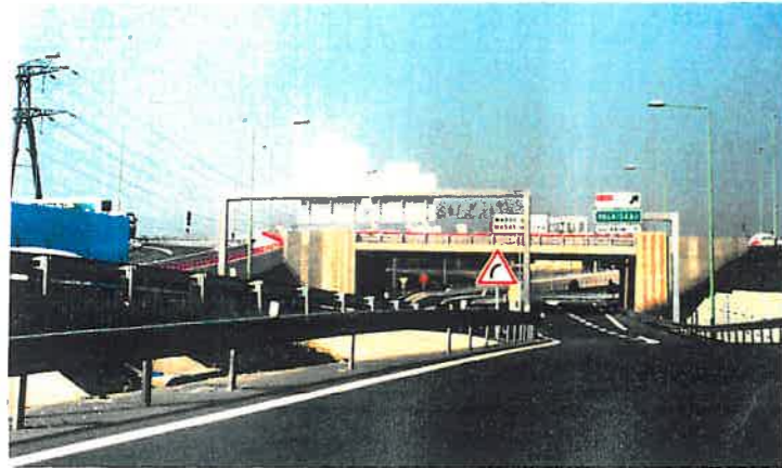
Croisement de voies routières
