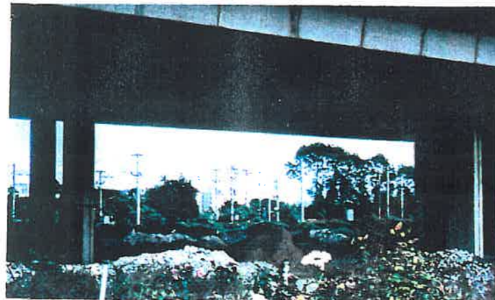
Espaces délaissés par les réseaux
