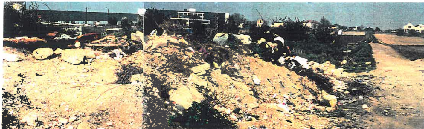
Zone de dégradation rapide
