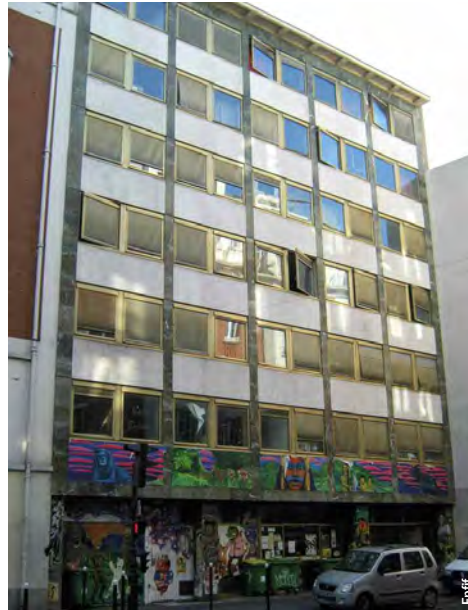
Exemple d'intervention de l'EPF dans le « diffus » parisien.
