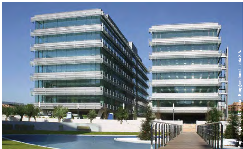
Cristalia, au nord-est de Madrid (Espagne), fait figure de référence en matière de parc d'affaires. Sur près de 10 hectares, cet ensemble rassemble 10 immeubles de bureaux, un hôtel, ainsi que 30 000 m 2 d'espaces communs avec jardins et installations sportives.
