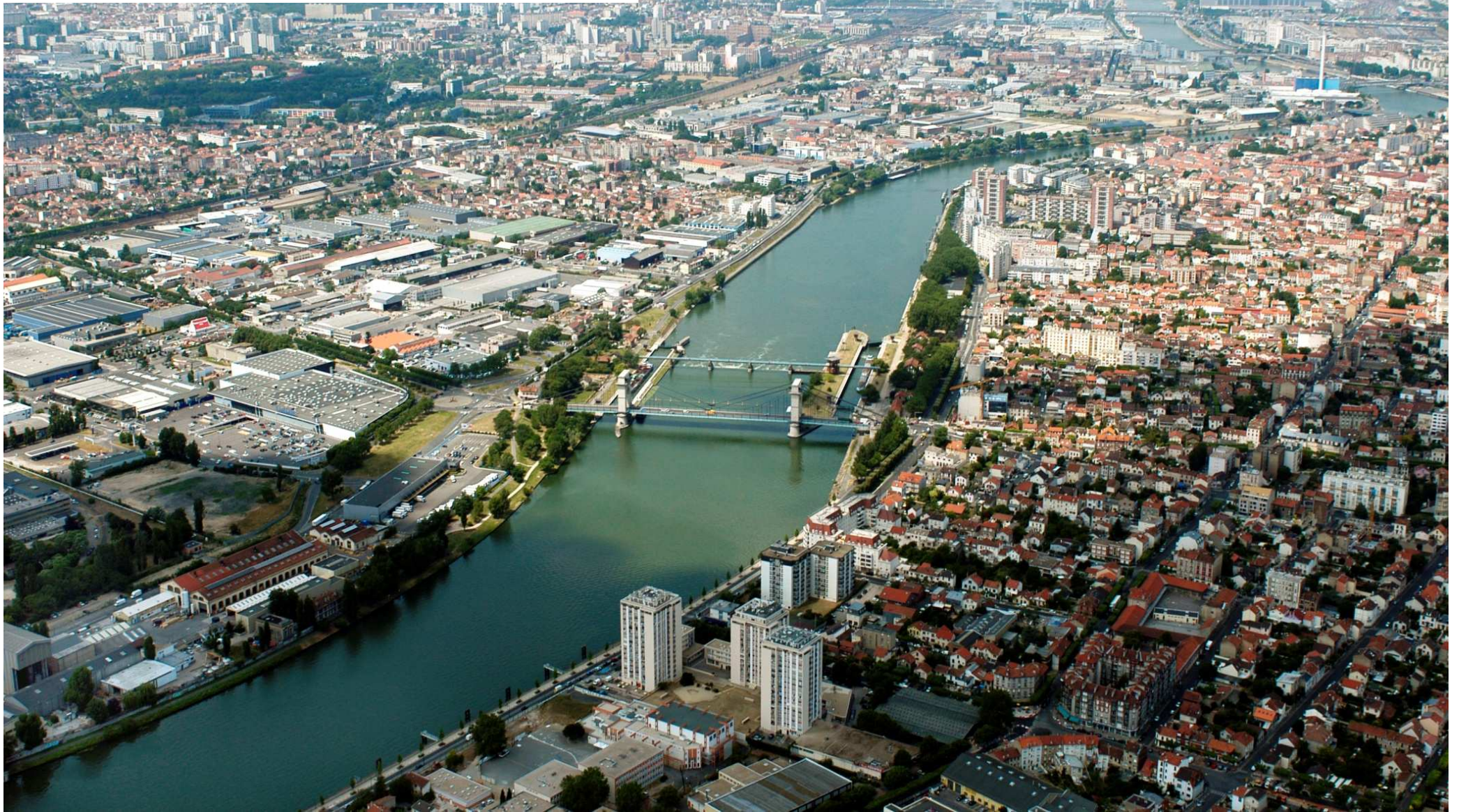
Alforville, Vitry sur Seine, Pont du Port à l'Anglais (panoramique) DREIF/GOBRY 03/07/2006
