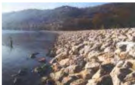
Artificialisation des berges
