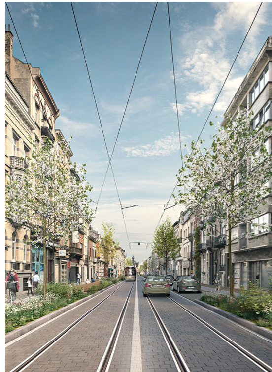
Projet de rénovation de voirie menée par la société de transport public bruxelloise. © STIB
