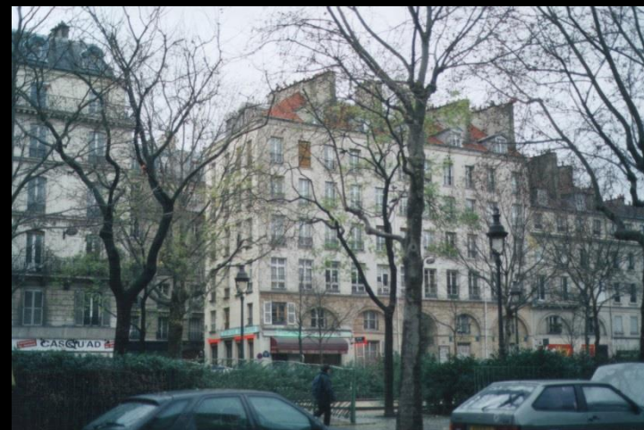
Immeuble construit dans les années 1830-1840, rive gauche, sur une emprise de la Nouvelle Ville d'Angoulême coupée par le canal Saint-Martin (actuel 140, boulevard Richard-Lenoir), 2010.
