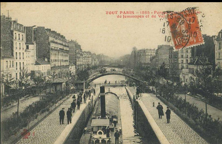
Passerelle et jardins réalisés au niveau des 5 ème et 6 ème écluses du canal Saint-Martin, vers 1930
