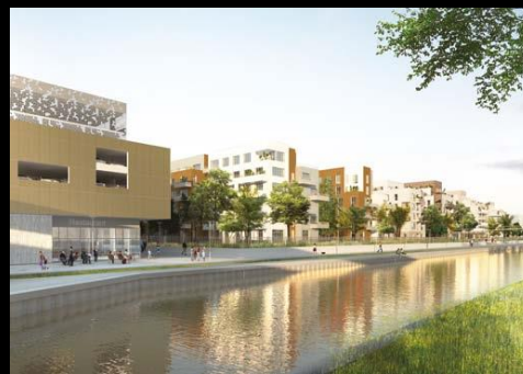
ZAC de la Plaine de l'Ourcq à Noisy-le-Sec Architecte Agence Myriam Szwarc / Aménageur Sequano Est-Ensemble
