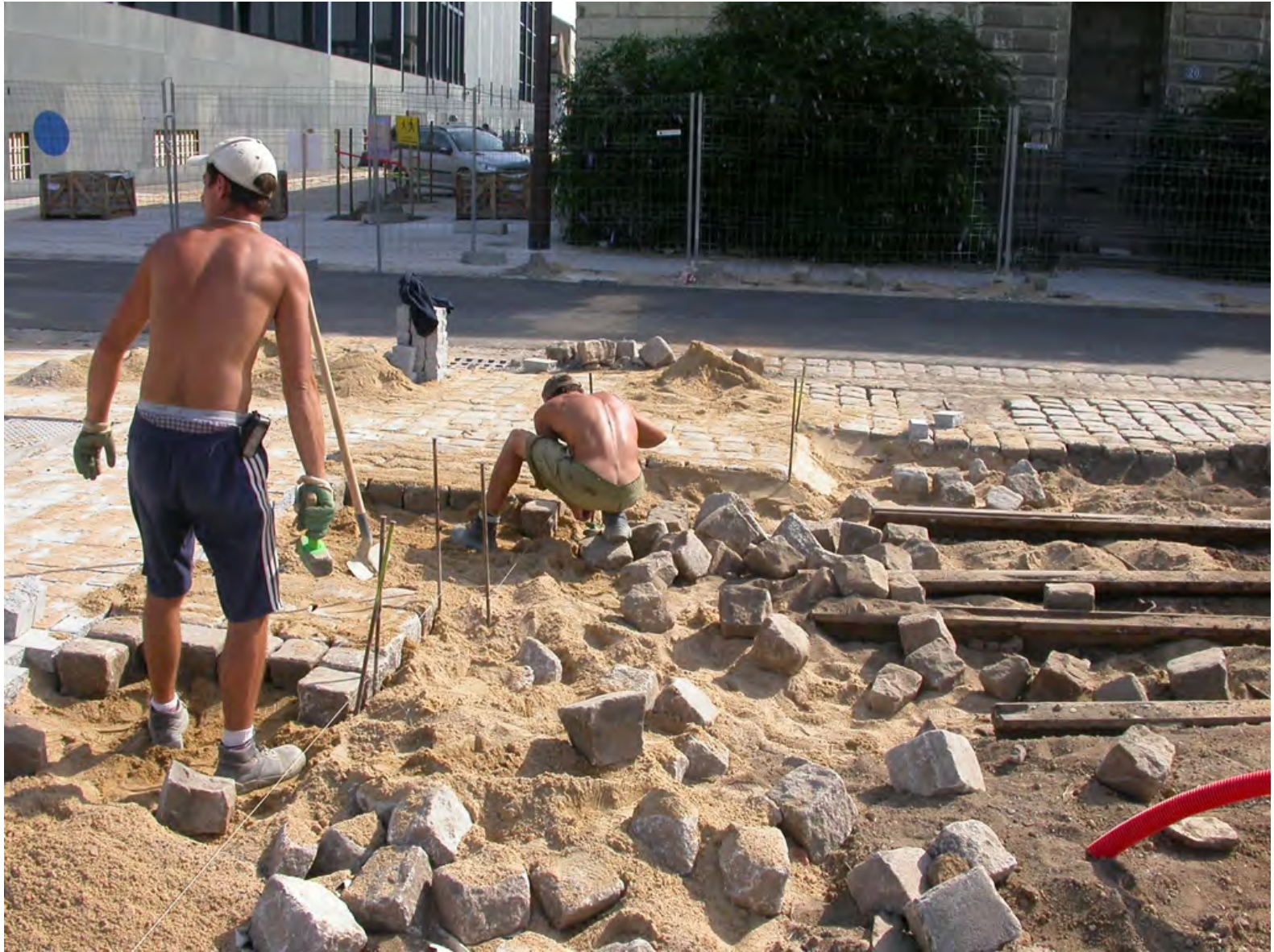
Récupération des pavés, quai François Mitterrand, île de Nantes, 2003.
