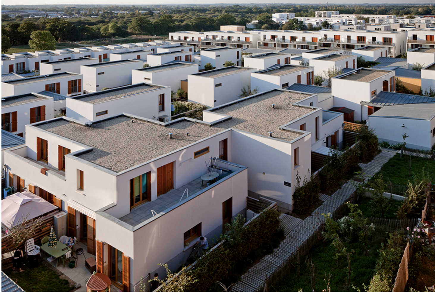
Le Village du Haut Bois à Saint-Jacques de la Lande (Ille et Villaine) - Architecte : Jean & Aline Harari - Photographie © Pierre-Yves Brunaud / PICTURETANK / C.A.U.E. 13
