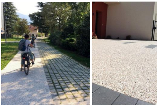
Revêtement drainant, pavés non jointés
