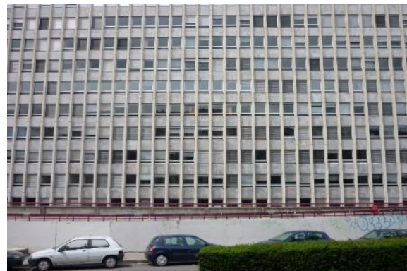
Immeuble de bureaux vacants appartenant à la CAF – Saint-Etienne
