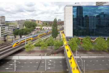
Passerelle en bois à Rotterdam
