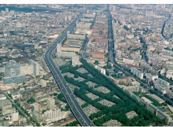
Le BP en viaduc sur la section nord, vue depuis la porte de Clichy (2000)
