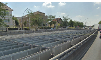
Couverture phonique de l'A6b au Kremlin-Bicêtre
