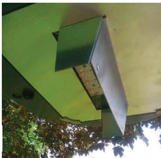
Image 8 : Lampadaire LED muni d'un coupe-flux, installé par la ville de Lille dans le cadre du projet Luciole. Extrait du guide Trame noire de l'OFB. Source : Yohann Tison, ville de Lille.
