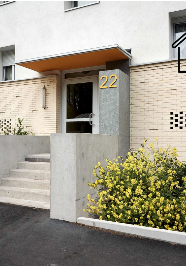
isoler les façades
