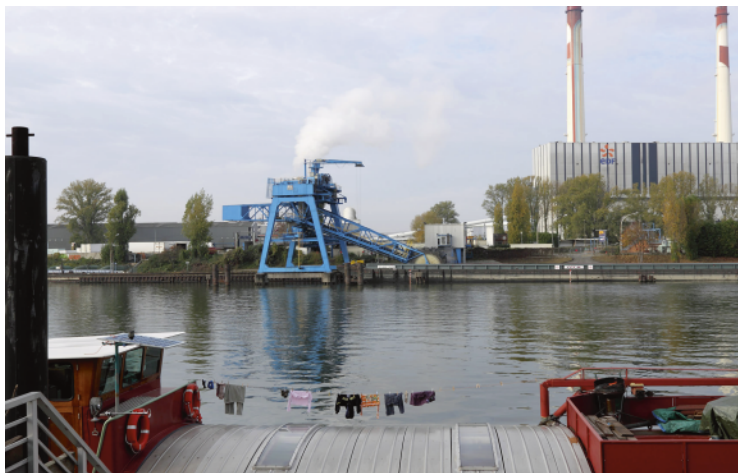
Usine thermique, Vitry-sur-Seine (94)
