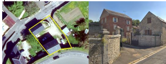
Restructuration interne du bâti d'un logement individuel pour la création de 3 logements collectifs (rue Jules Ferry, Saint-Clair-sur-Epte, 2008)
