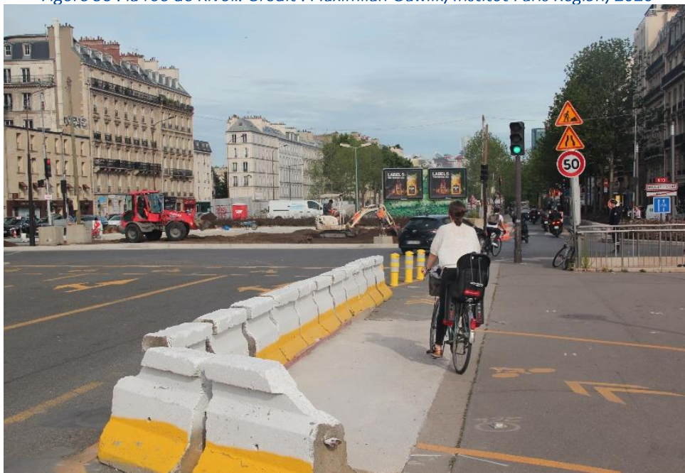
Figure 37 : la Place de Maillot à Paris (actuellement en travaux) propose une nouvelle continuité temporaire pour les cyclistes en direction de Neuilly-sur-Seine/La Défense. Crédit : Maximilian Gawlik, L'Institut Paris Region, 2020
