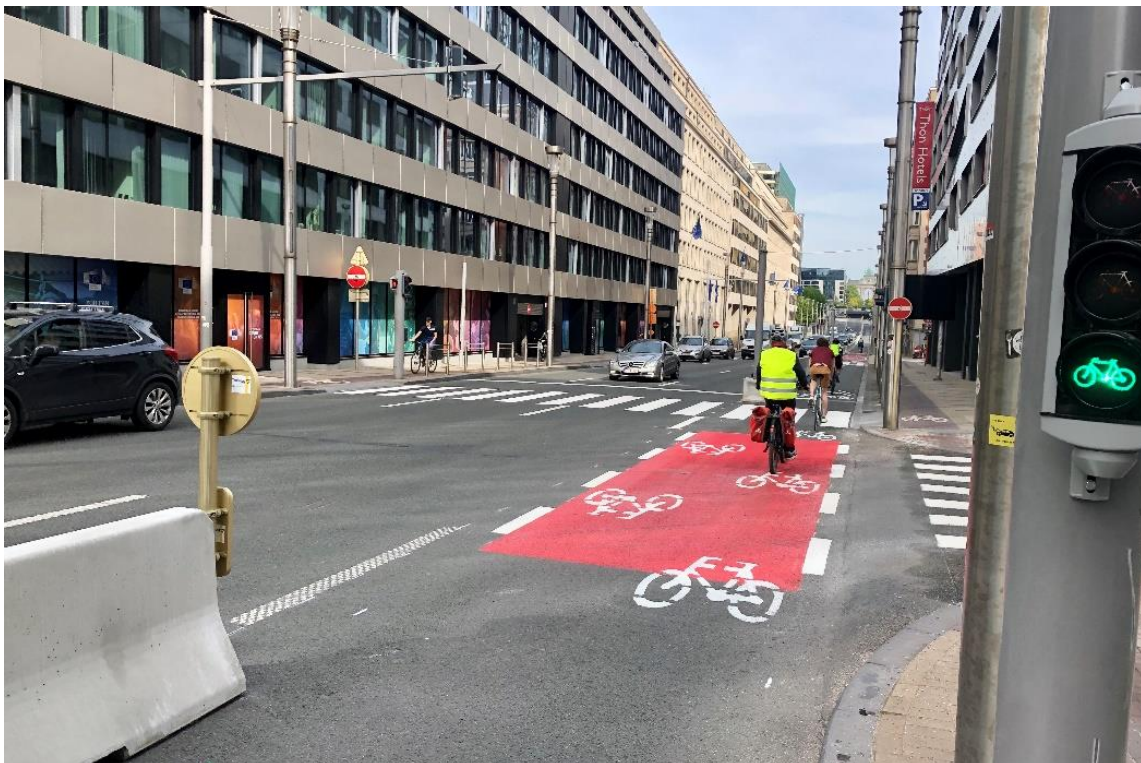
Figure 19 : l'aménagement cyclable sur la rue de la Loi à Bruxelles. Crédit : Tim Gatzios
