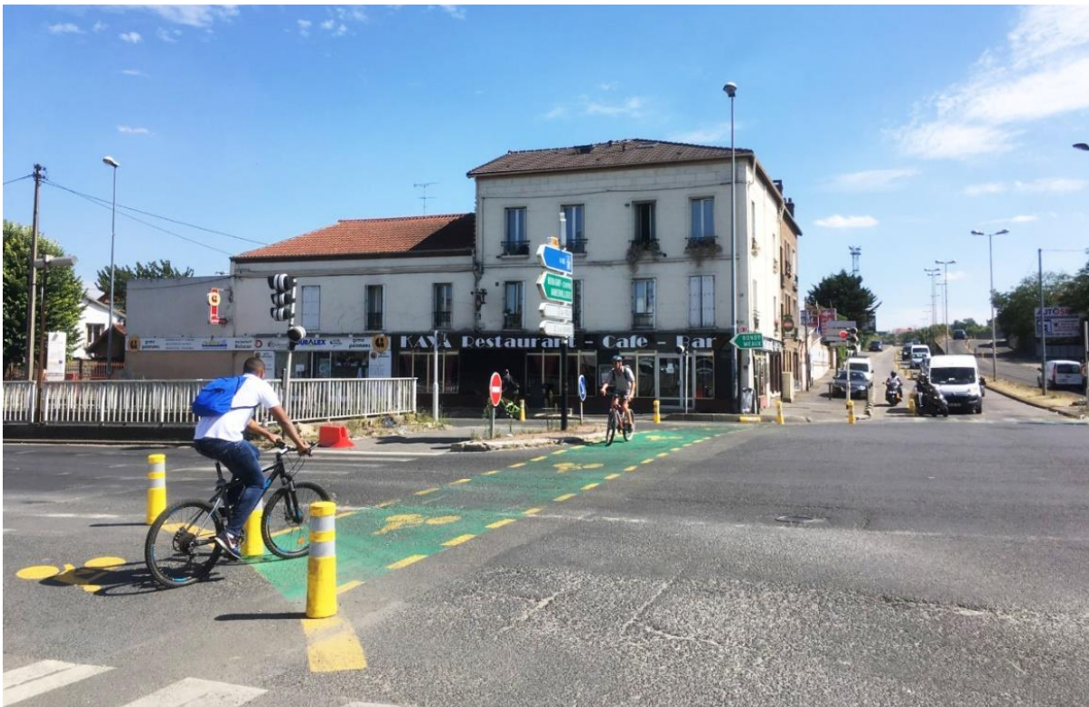
Figure 50 : intersection Rue de Paris et Rue du Parc, Bobigny. Crédit : Maximilian Gawlik, Institut Paris Region, 2020
