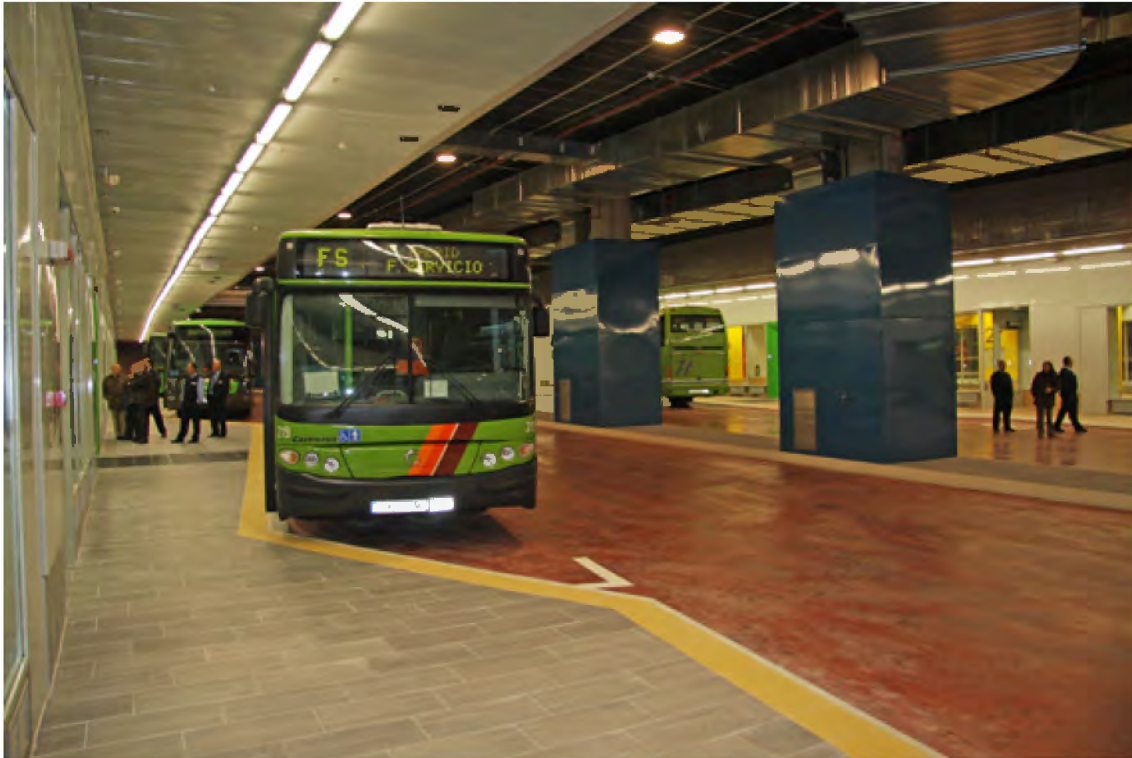
La voie bus se termine en souterrain à Moncloa, juste au-dessus des voies du métro © Ofitep
