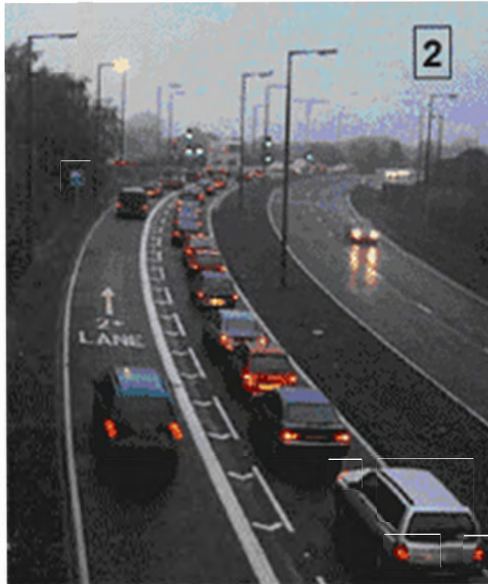
La voie VOM du Stanningley Bypass (A647) en entrée de Leeds © Leeds City Council
