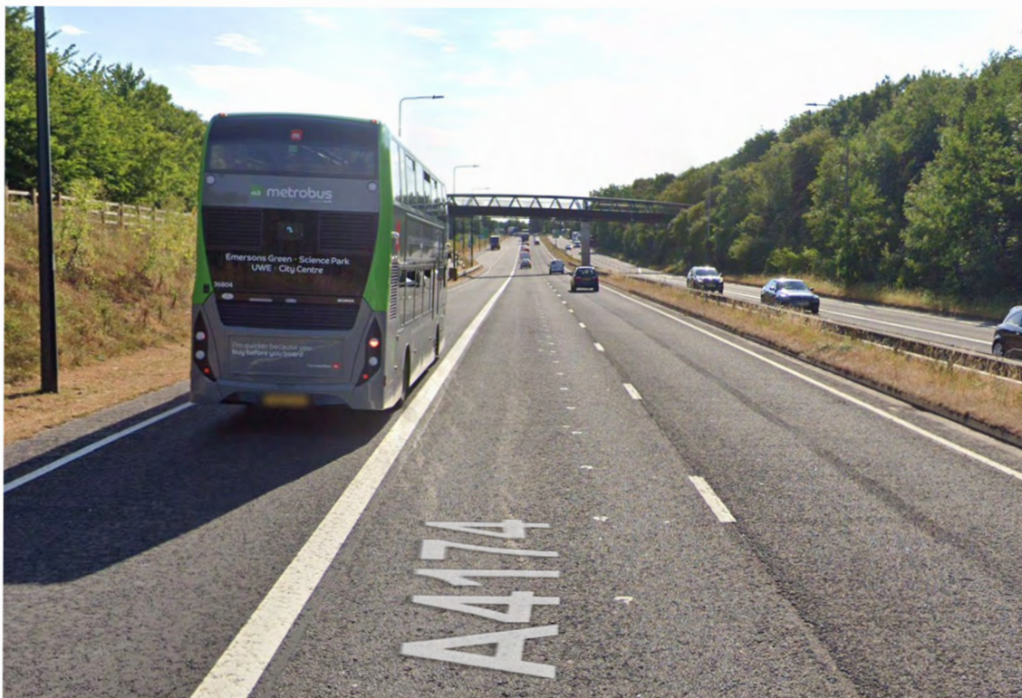
La ligne de MetroBus M3 sur la A4174 en direction du parc relais d'Emersons Green Sur ce tronçon, la chaussée a été élargie pour créer une troisième voie réservée aux bus. © Google Street View (2018)
