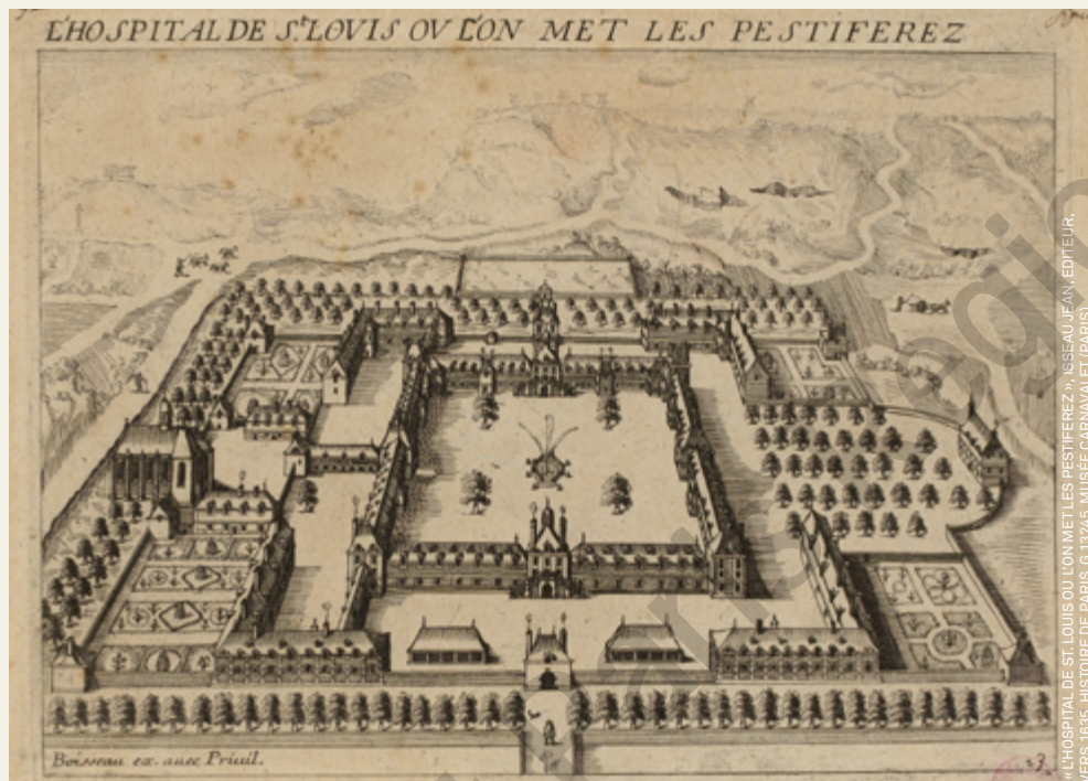
Estampe du XVII e siècle de l'hôpital Saint-Louis : une organisation nouvelle, en pavillons, pour éviter les contagions.
