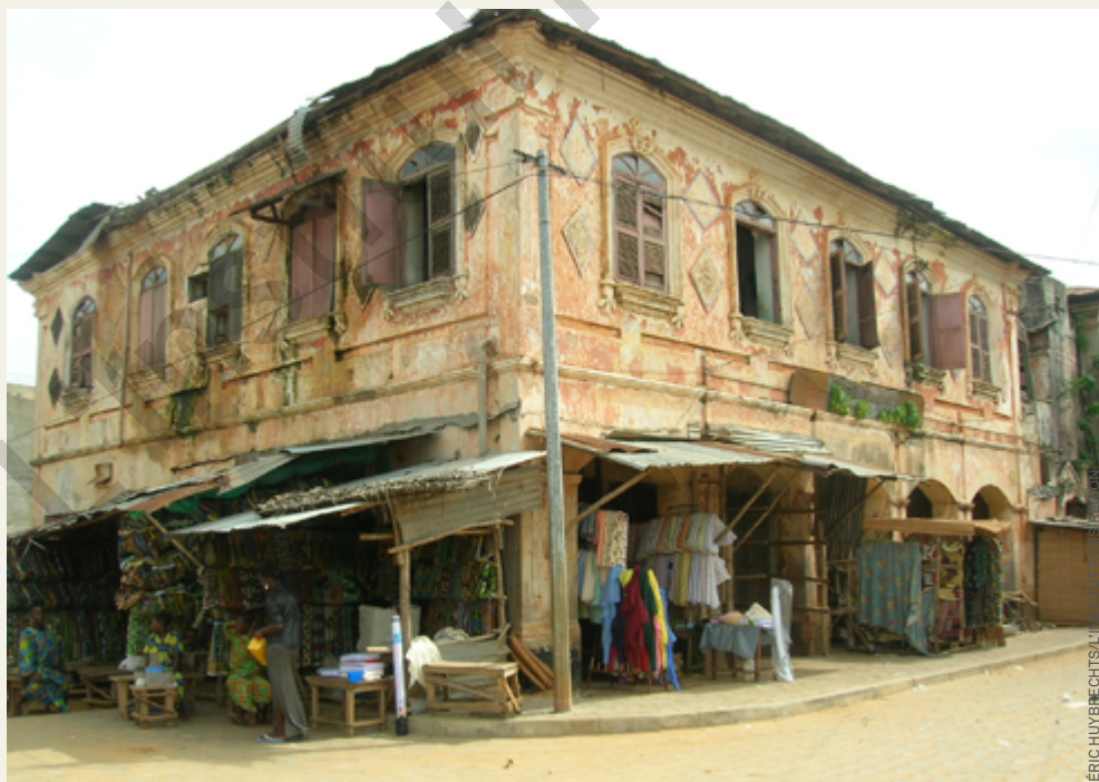
La maison du Patrimoine de Porto-Novo, avant restauration.
