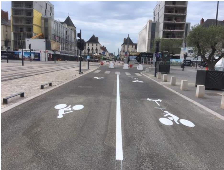
Figure 19 : le pont Wilson à Tours. Crédit : Fabrice Houllier, Métropole de Tours.
