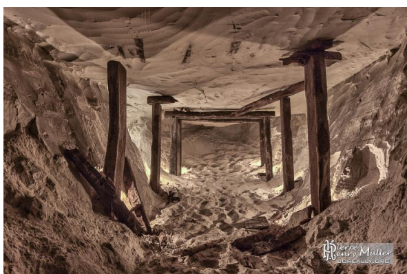
Consolidation des galeries par des madriers de bois dans la carrière de sable du Puiset
