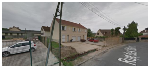
Opération réalisée en 2012 de démolition-reconstruction avec la création de 2 maisons jumelées
