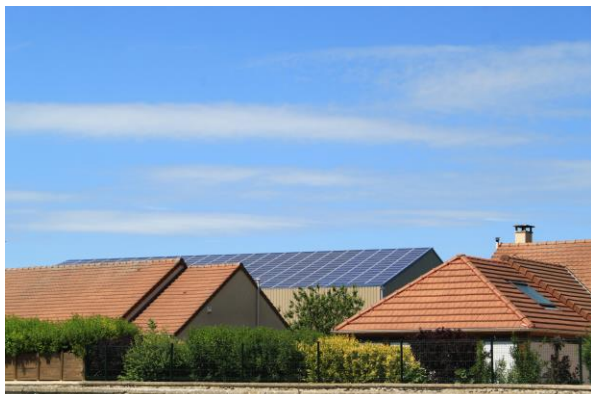
Panneaux solaires sur un bâtiment agricole à Roinvilliers
