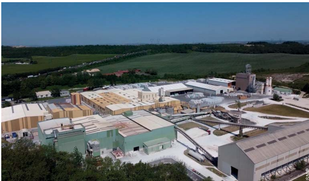
◀ Usine de fabrication de poudres et de carreaux de plâtre (Le Pin, 77).
