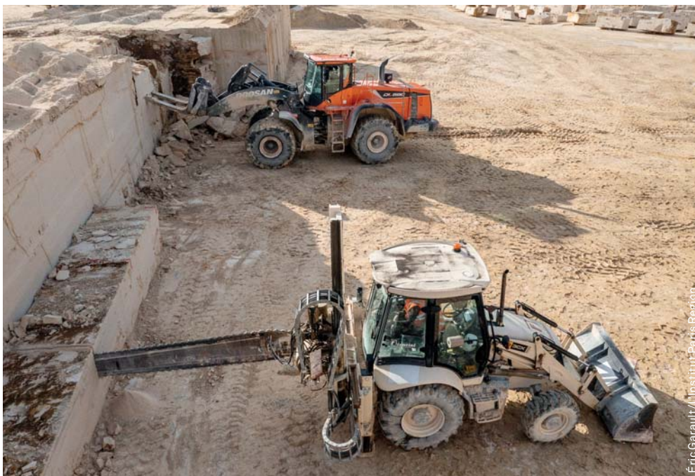
▲ Exploitation de calcaires pour pierres dimensionnelles (Souppes-sur-Loing, 77).
