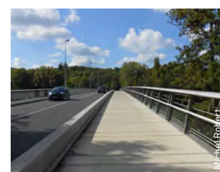
Passerelle du pont de Samoreau (Seine-et-Marne)
