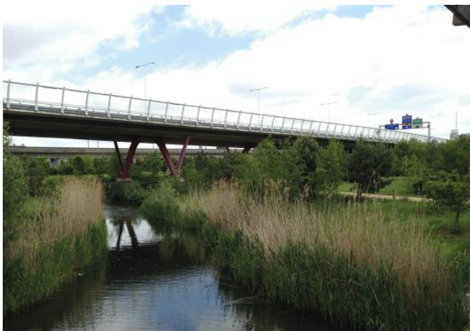
Aménagements des abords du parc du chemin de l'île, alimenté par l'eau de la Seine.
