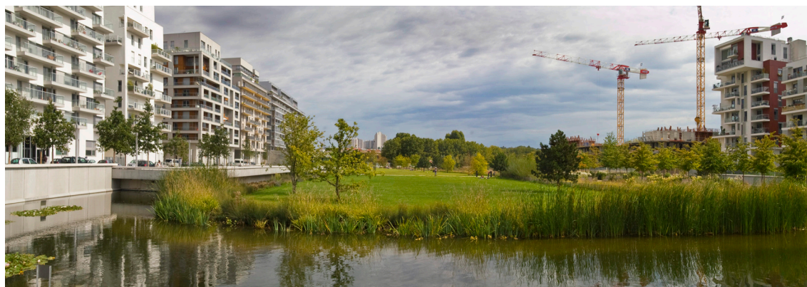
Boulogne-Billancourt - ZAC du Trapèze – La trame verte des nouveaux quartiers participe à la renaturation des rives du fleuve
