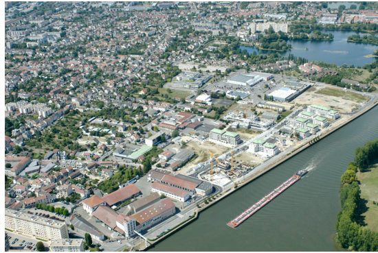
Mantes-la-Jolie – La ZAC Bord de Seine a été réalisée sur une ancienne friche
