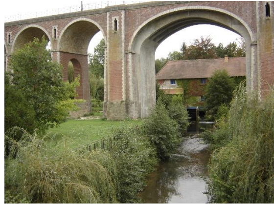
Moulin du Gué-Plat et viaduc SNCF sur l'Aubetin, Pommeuse
