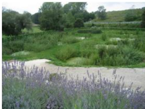
Zone de rejet végétalisée sur la station de Bouleurs
