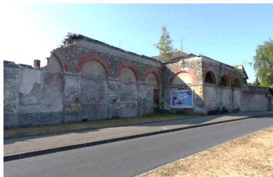
Anciens ateliers Gueuvin-Bouchon et C ie à La Ferté-sous-Jouarre, en ruines, témoignage de l'ancien commerce des meules
