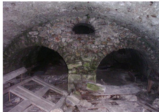
Souterrain abandonné, Crécy-la-Chapelle
