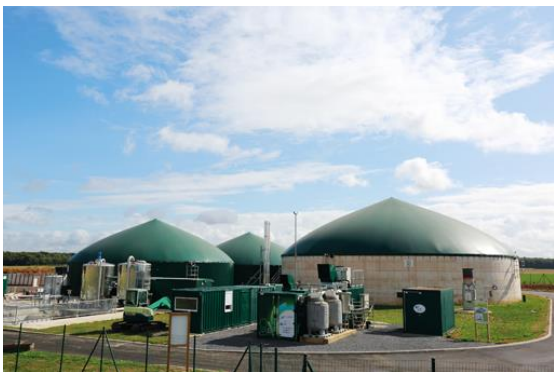
Les installations de méthanisation par injection de la Ferme d'Arcy à Chaumes-en-Brie
