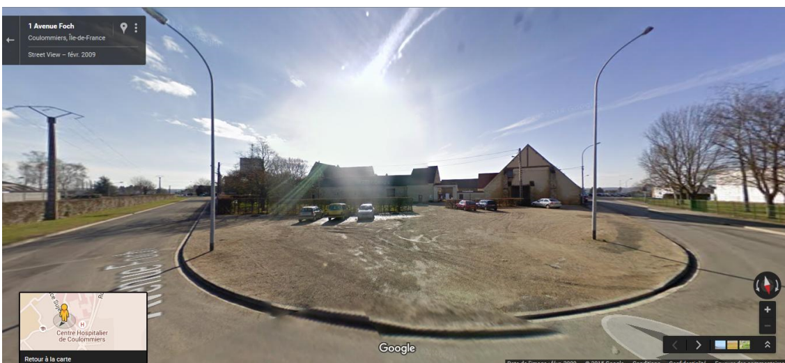
Vue de l'entrée (nord)
