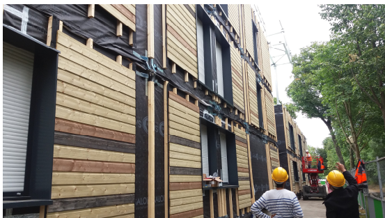
Construction du site de la Promesse de l'Aube conçu par Moonarchitecture et AIRarchitectures Crédit photo : Association Aurore
