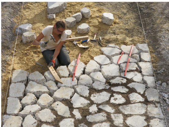
Construction de l'Opus Incertum, par Bellastock, un chemin constitué de 100% de matériaux récupérés in situ sur le site Actlab à l'île-saint-Denis (le béton est issu de la structure des entrepôts du Printemps en déconstruction)
