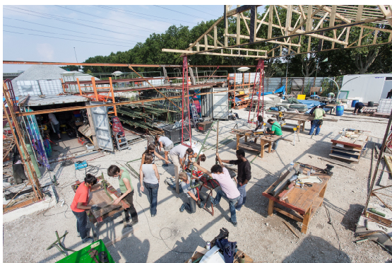
Le laboratoire Actlab en cours de construction Bellastock, Île-Saint Denis Crédit photo : Alexis Leclercq
