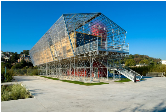
Les grandes tables de l'île Seguin à Boulogne Billancourt, espace démontable sur le principe d'un échafaudage Projet conçu par 1024 architecture Crédit : Les Grandes tables de l'île Seguin / 1024 architecture Photo : Cyril SANCEREAU
