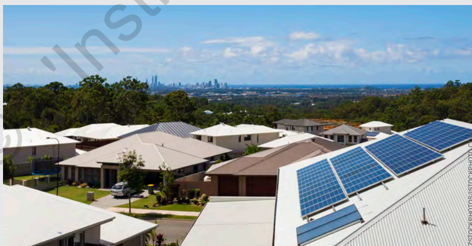
Très gourmandes en énergie fossile, les villes australiennes passent au solaire, Perth.
