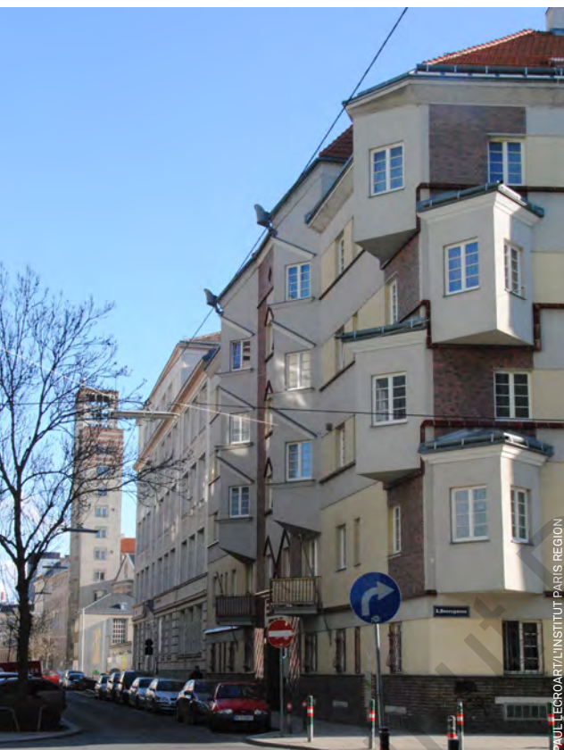
Le stock de 220 000 appartements municipaux est régulièrement renoué selon les standards actuels (immeuble sur la Drurygasse).
