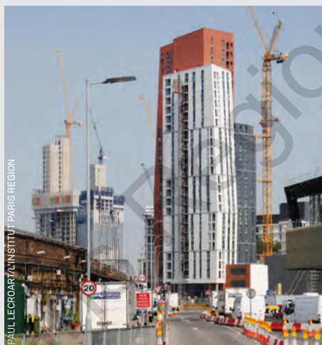
Nouvelles tours en construction à Nine Elms.
